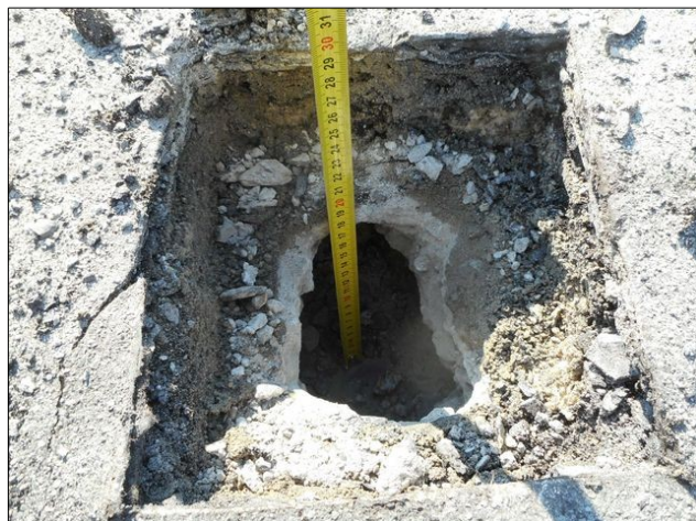
foto 7/ Pohled na provedenou sondu S15
