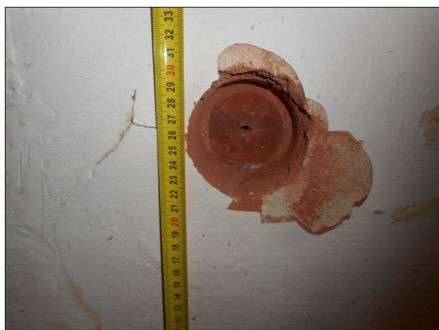
foto /13/ Pohled na sondu S06 na vnitřní nosné stěně
