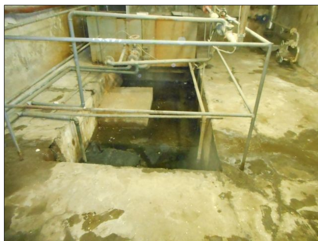
foto /28/ Vlhkostní poruchy v suterénu
