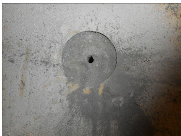
foto /20/ Pohled na odběr vzorků z podlahy 1.NP nad suterénem S10
