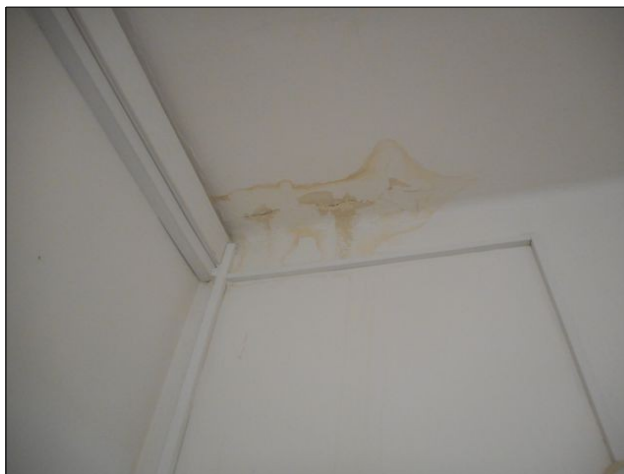
foto /22/ Vlhkostní poruchy na stropní konstrukci z interiéru
