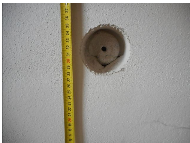
foto /11/ Pohled na sondu S04 na stěně ke skleníku – v místě zazdění otvoru
