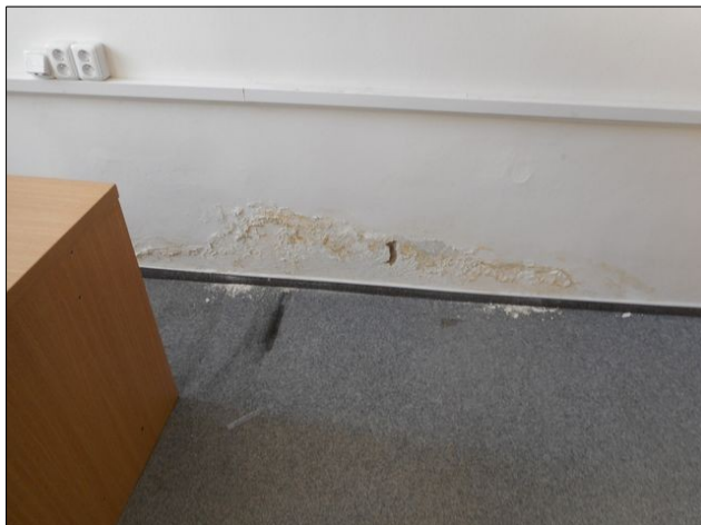
foto /23/ Vlhkostní poruchy na vnitřní nosné stěně
