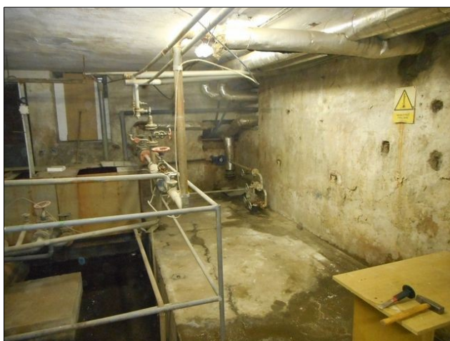
foto /27/ Vlhkostní poruchy v suterénu
