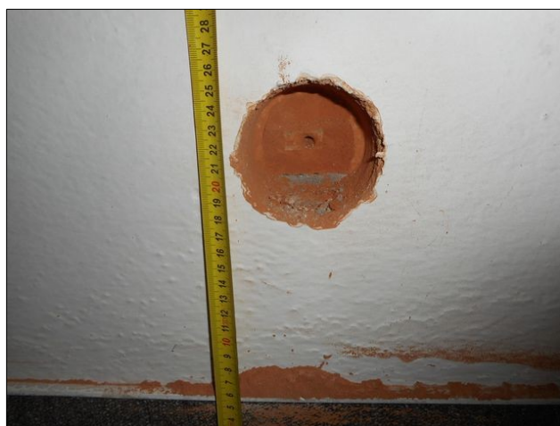
foto /12/ Pohled na sondu S05 na obvodové stěně
